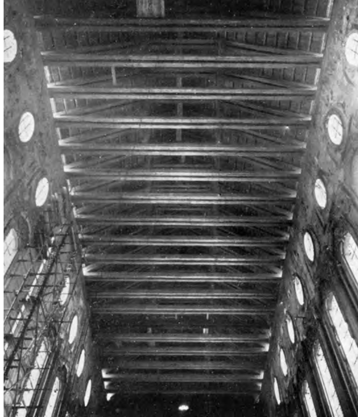
SANTA CHIARA, NAPLES. Wooden ceiling during the reconstruction. Image: La ricostruzione del patrimonio artistico italiano, Roma, 1950.
