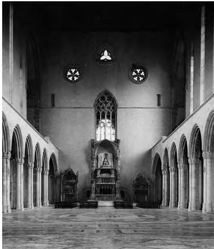
SANTA CHIARA, NAPLES. Interior, after the restoration. Image: G Dell'Aja, Il restauro della Basilica di Santa Chiara in Napoli, Napoli, 1980.
