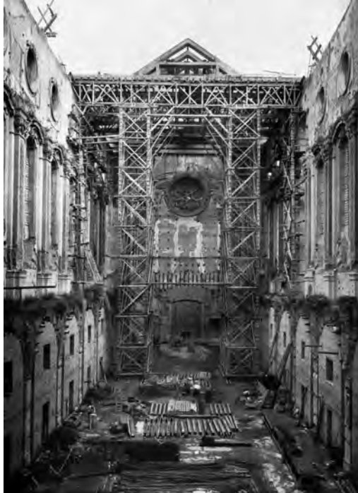
SANTA CHIARA EN EL INICIO DE LOS TRABAJOS. Imagen: La ricostruzione del patrimonio artistico italiano, Roma. 1950.
