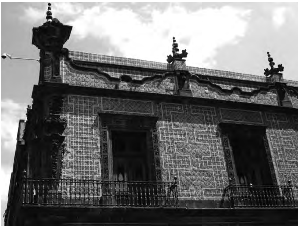
CASA DE LOS AZULEJOS, CIUDAD DE MÉXICO. Imagen: Valerie Magar.
