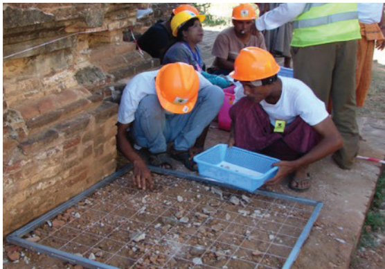
Ցանց՝ Պագոդայի գիպսից զարդանախշերի փոքր բեկորները դուրս բերելու համար, Բադան, Մյանմար, 2016 թ: Լուսանկարը՝ ICCROM
