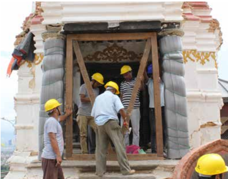
Կարմանդոլի փրճարում արվակարգ իրավիճակի կայունացում, Նեպալ, 2015թ.: Լուսանկարը ICCROM-ի:
