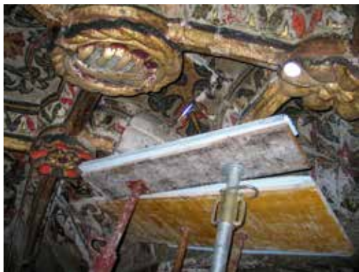
Պաշտպանիչ և մեկուսիչ շերտ որմնանկարի և հենարանի միջև Ֆրեյշու-դի-Էշպադա-Սինյա եկեղեցում, Պորտուգալիա, 2007թ.: Լուսանկարը՝ էմերալդա Պաուպերիոյի:
