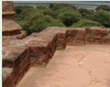
Ճաքեր փաճարի փանիքում, Բագան, Մյանմա, 2016թ.: Լուսանկարը՝ Էժենի Կրեպեի:
