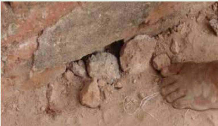
Անցքեր Բագանում պագոդայի փանիքի ջրամեկուսիչ համակարգում, Մյանմա, 2016թ.: Լուսանկարը՝ Էժենի Կրեպեի:
