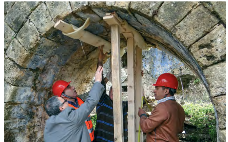
Тренування з екстреної стабілізації конструкцій на воркиопі в Шуфі, Ліван, 2014. Світлина: ICCROM-ATHAR
