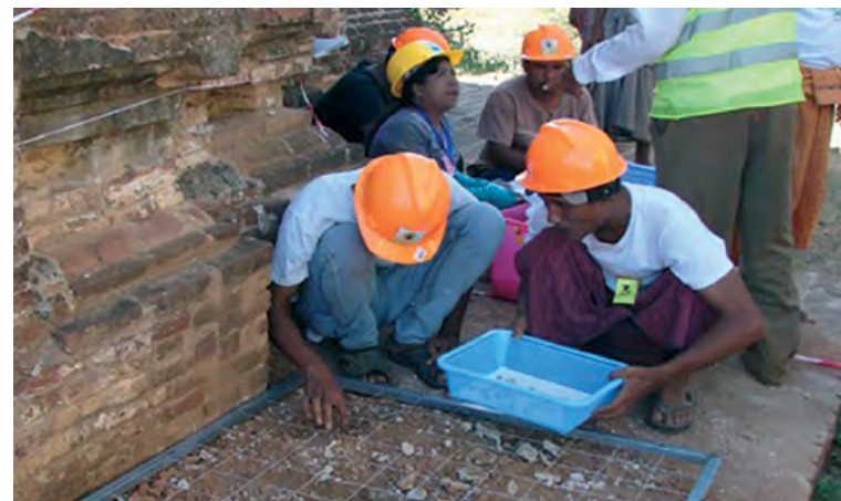
Сітка для вилучення дрібних фрагментів ліпного декору в пагоді в Багані, М'янма, 2016. Світлина: ICCROM
