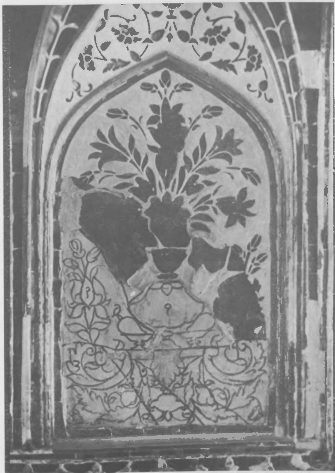
Tav. 44 - Fort Amber (Rajasthan). Decorazione con pittura e intarsio di pietre semi-preziose. Il distacco dell'intonaco nella zona inferiore di una nicchia rivela la presenza della sinopia (in nero) sull'arriccio sottostante. Il motivo di questa fase preparatoria è certamente quello di definire in anticipo la posizione dei diversi materiali da inserire nella pittura. Questo è presumibilmente il significato dei segni su alcune parti del disegno (part. della Tav. 43).
