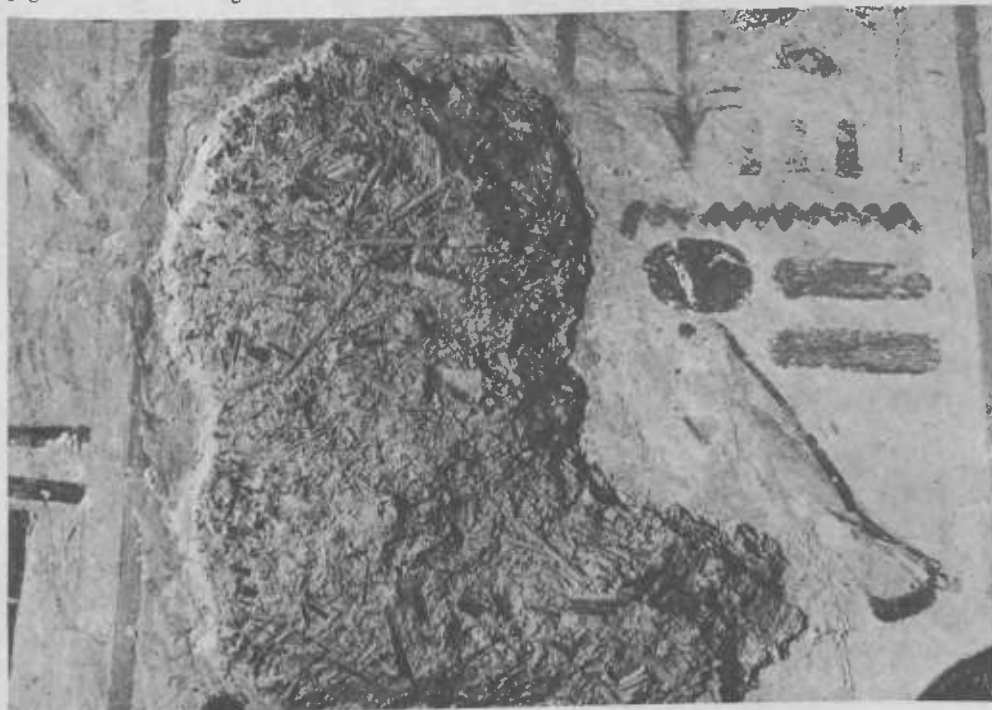
Tav. 34 - Tomba egizia, XVIII dinastia. Particolare della pittura deteriorata che mostra l'arriccio di argilla e di paglia sotto l'intonaco di gesso.
