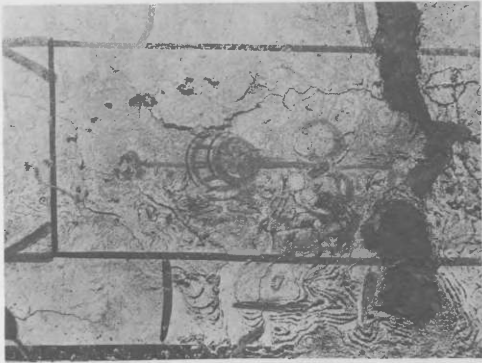
Tav. 125 - Casa romana del III sec. sotto le catacombe di San Sebastiano. Alterazioni dovute all'umidità; cristallizzazione del sale lungo le linee (traquelliere) di più rapido essiccamento della pittura.
