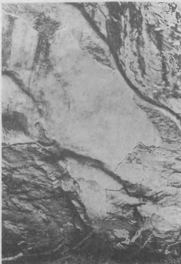
Tav. 4 - Sigiriya (Sri Lanka). Particolare di un ambiente sotto la montagna che mostra la volta rocciosa non tagliata ma coperta da un'imprimitura dipinta e protetta dal ruscellamento pluviale mediante un canale che svolge la funzione di gronda.
