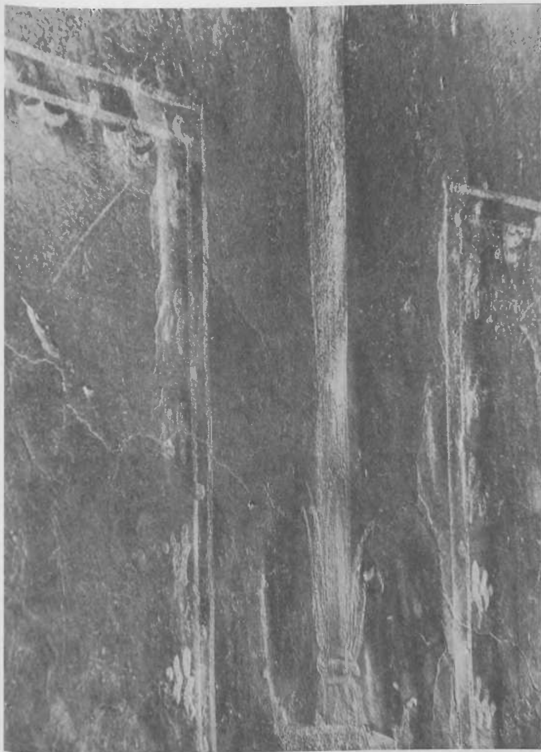
Tav. 25 - Ercolano, casa non determinata. La luce riflessa mette in risalto le leggere depressioni superficiali dovute alla levigatura locale degli elementi decorativi.
