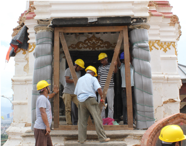
التثبيت الطارئ لأحد المعابد في مدينة كاتماندو، نيبال، ٢٠١٥. الصورة: إيكروم.
