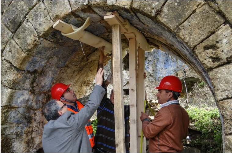
تطبيق عملي لتثبيت الحالة في حالات الطوارئ في ورشة عمل بالشوف، لبنان، ٢٠١٤. الصورة: إيكروم آثار.
