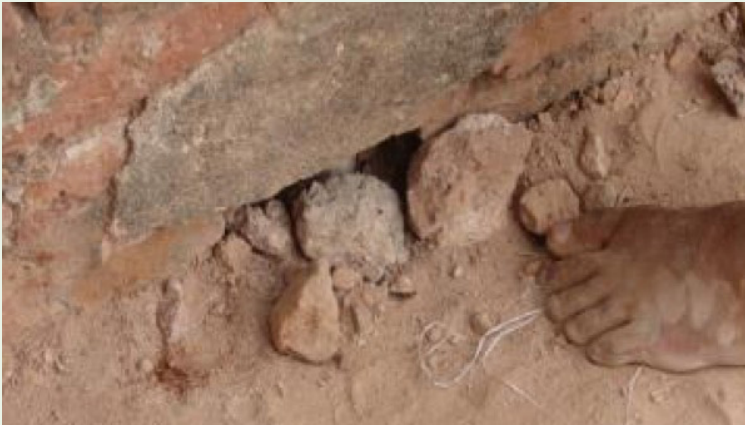
فتحات في أنظمة منع تسرب المياه بالسطح في باجودا، باجان، ميانمار، ٢٠١٦. الصورة: إوجيني كريتيه.
