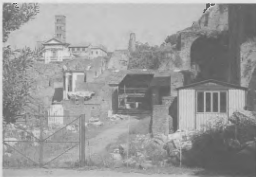
Le chantier de l'Oratoire des XL martyrs dans le forum romain.
